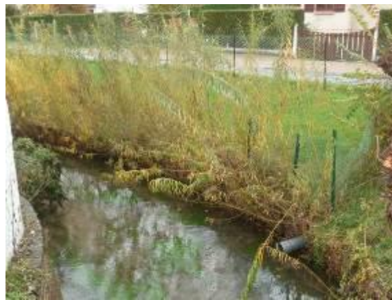
Talutage et fascines de branches de saule vivant, après repousse
