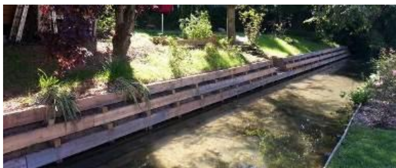
Caisson végétalisé (avant plantations et boutures)
