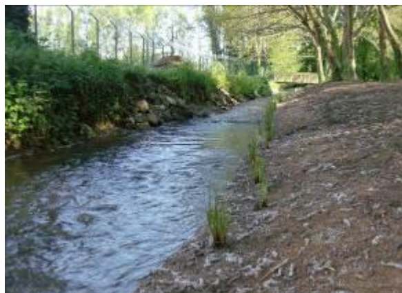
A gauche, berge érodée constituée de gravats de briques, à droite, berge reprofilée en pente douce et plantation d'hélophytes
